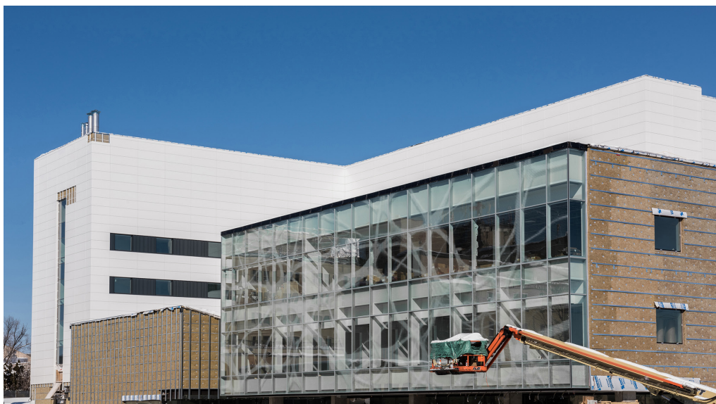
Construction du nouveau pavillon de soins en santé mentale de Saint-Jérôme
