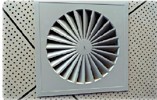
(32) La grille du ventilateur doit aussi être propre et non-obstruée (33). Il est nécessaire de nettoyer régulièrement les ventilateurs pour qu'ils gardent leur efficacité. (32)
